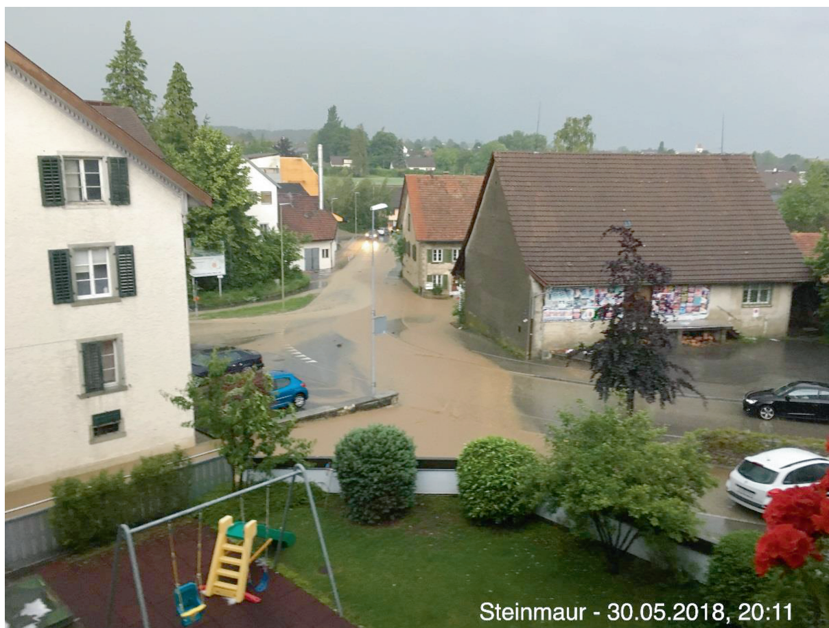
Hochwasser in Niedersteinmaur am 30. Mai 2018. Quelle: Müller Ingenieure AG
