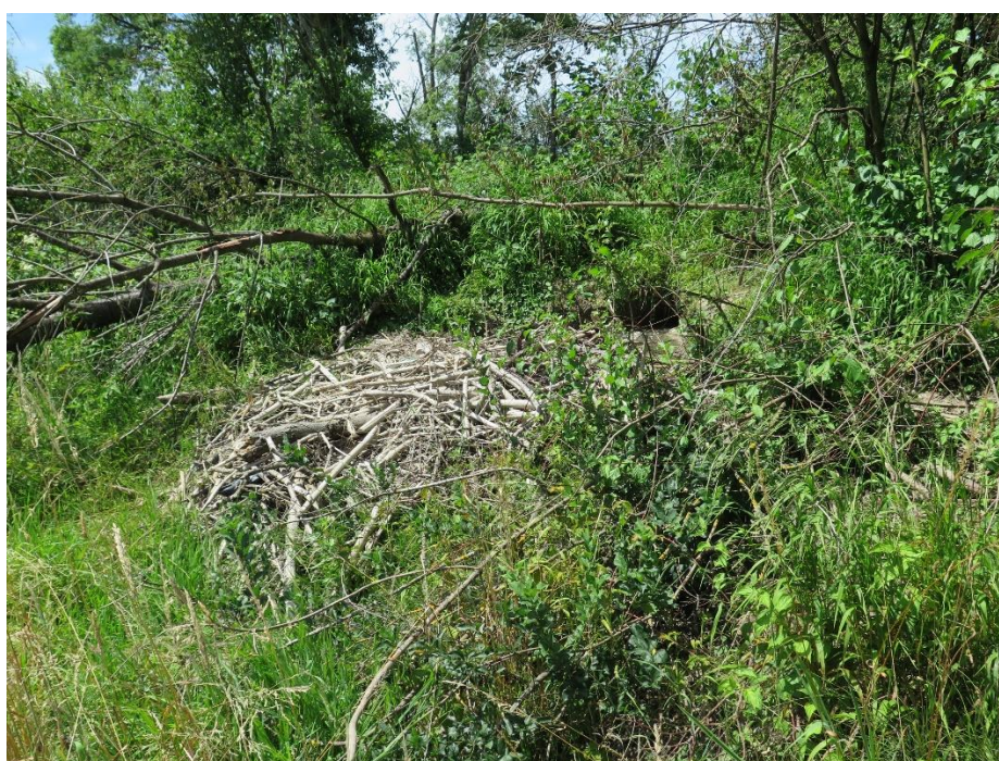
Abbildung 7: Biberbau und Saum auf dem östlichen Damm. Diese Grabaktivitäten führten zu einem Wasserdurchbruch. Foto Tobias Liechti.
